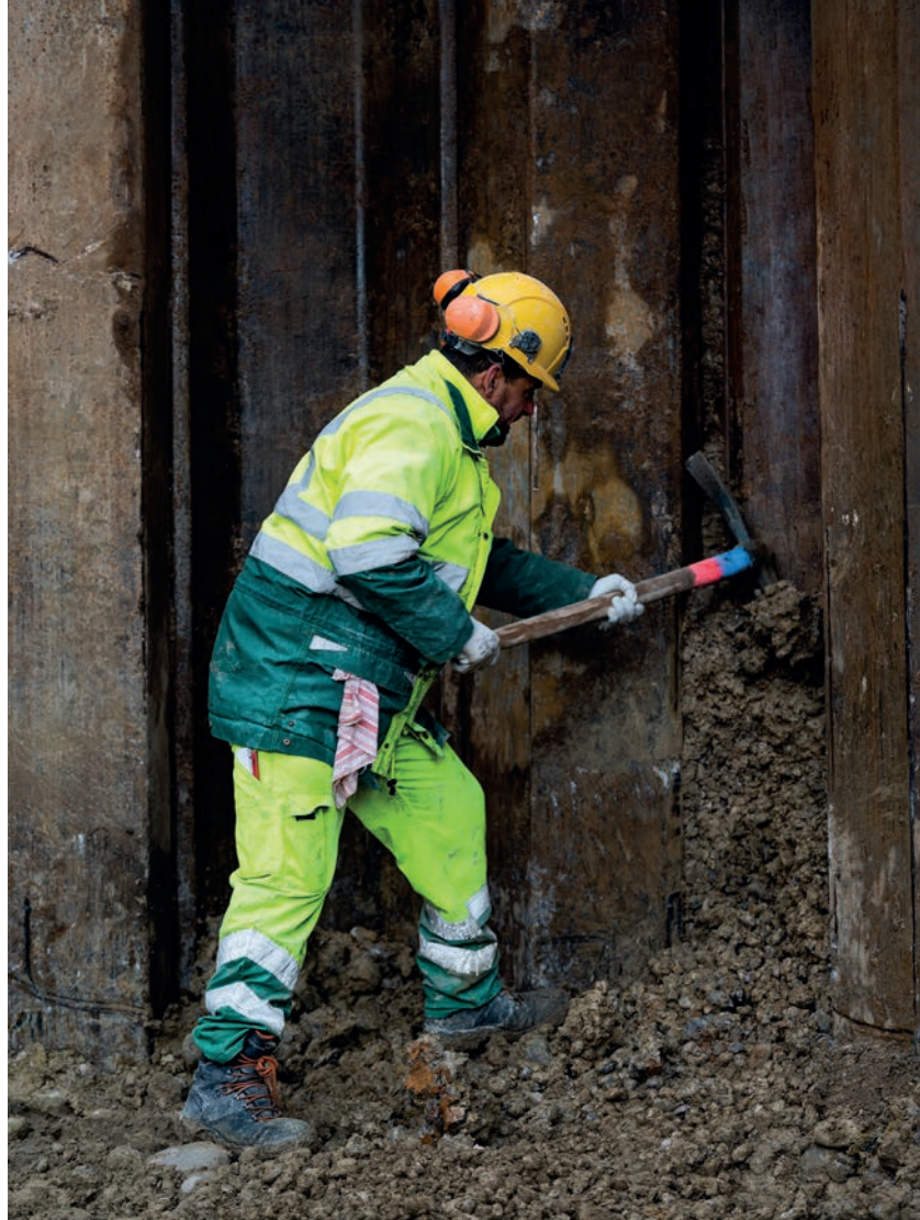
Die Pfungener Baugrube wird auf der einen Seite durch eine Spundwand und auf der anderen Seite durch eine Baumeister-Rühlwand gesichert.
