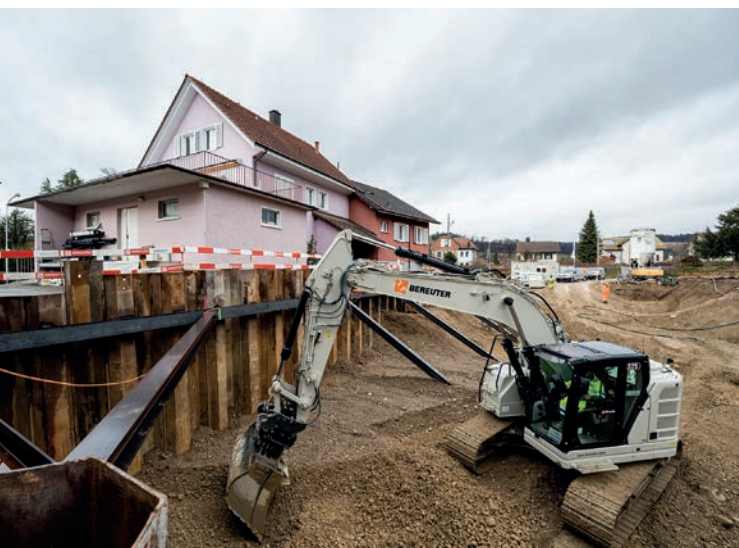
Die Pfungener Baugrube wird auf der einen Seite durch eine Spundwand und auf der anderen Seite durch eine Baumeister-Rühlwand gesichert.
