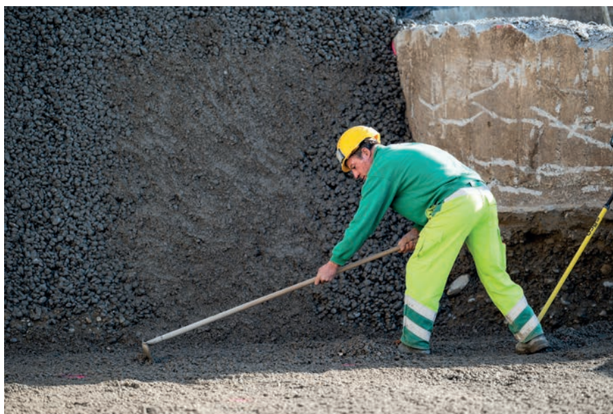
Mit dem Pneu-lader (oben) wird die Betonanlage (mitte) mit Mischgranulat versorgt. Zu Magerbeton verarbeitet, wird das RC-Material neu eingebaut.
